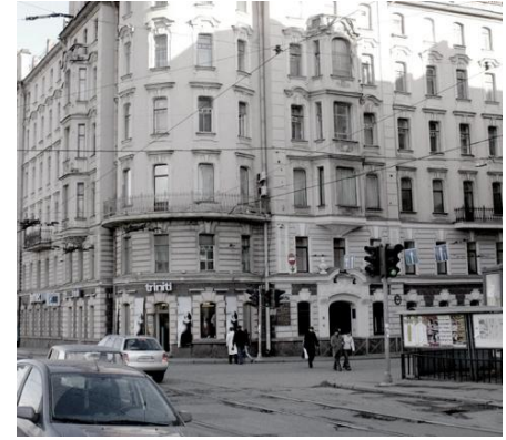
Apartment buildings, αρχές 20ου. αι., Ρωσία
