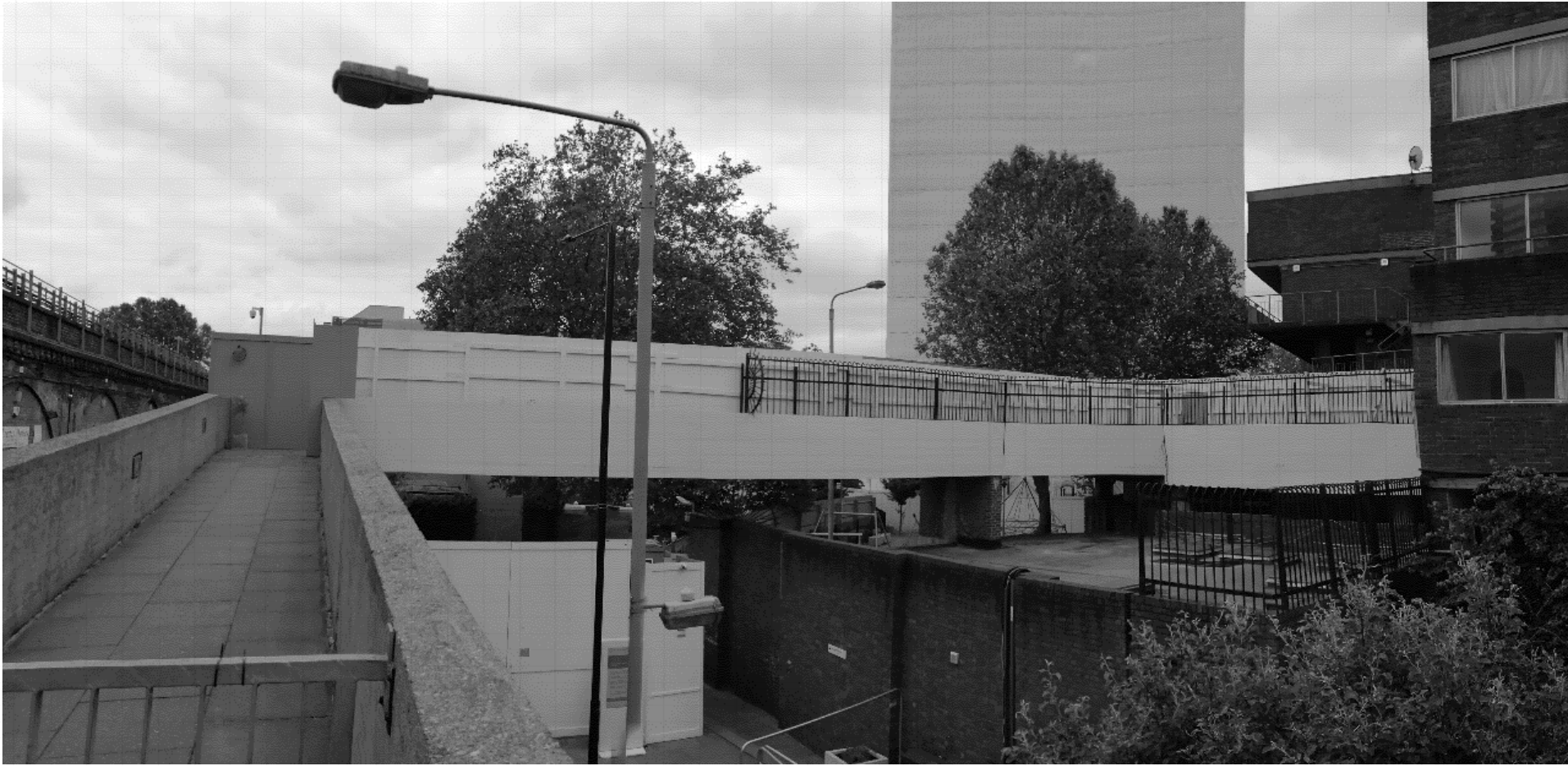
Είσοδος από τον σταθμό του μετρό και χρήση της υπάρχουσας ράμπας.
